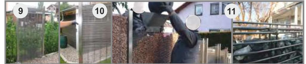
9. Das erste Element (zwei Pfosten mit Korb) auf dem Fundament genau ausrichten und befestigen.
